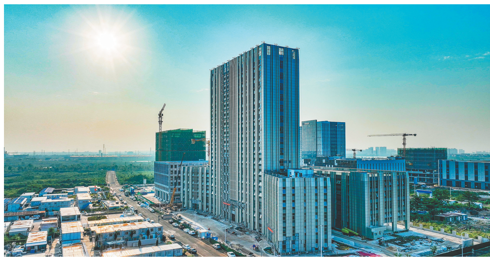
海口民银国际科创中心项目 冲刺年内竣工
