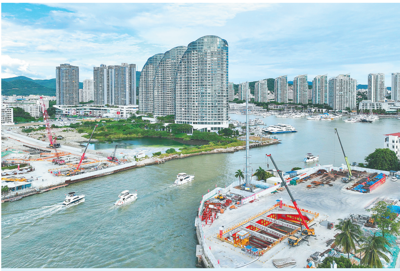
三亚河：10月16日，位于三亚市天涯区的三亚河通道工程项目稳步推进建设。该项目由中铁二十局承建，创新采用三圆咬合顶管施工工艺，通过管幕结构加冷冻法施工工法的全海底作业方式，确保大量游艇游船进出港不受施工影响，有效保护周边海洋生态。海南日报全媒体记者 王程龙 摄
