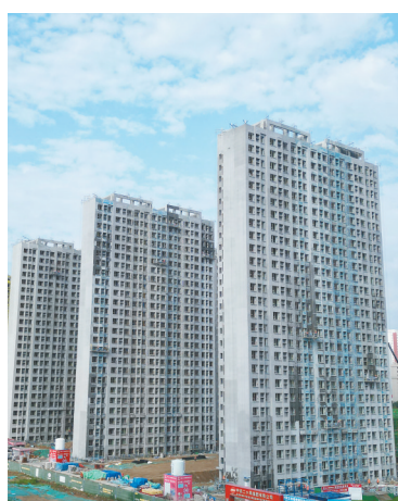
河北省保定市城中村改造三期工程南刘各庄村安置区项目建筑工地。 新华社发
