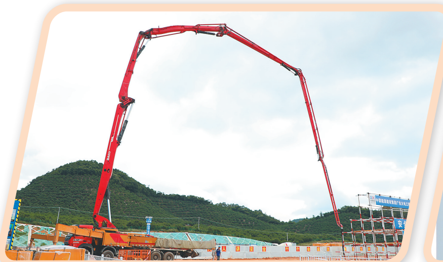
海南500千伏数字电网主网架工程建设全面启动。宋印官 摄
