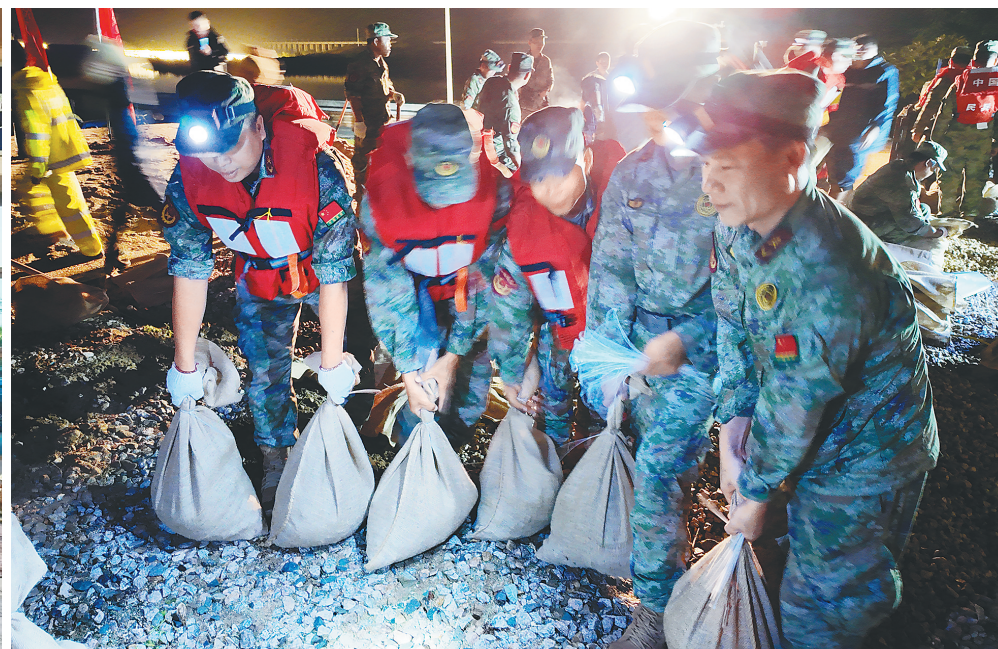
10月30日晚，三亚天涯区人武部组织35名民兵奔赴布甫村布山水库溢洪道下方海漫段塌方处进行决口围堵抢修。 肖剑波 摄
