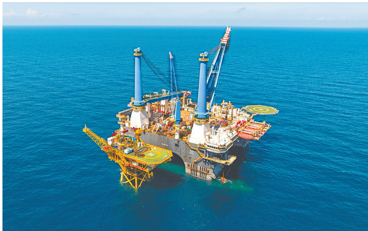
近日,东方29-1气田新建生产平台在海南莺歌海海域安装就位。 汪洋 摄
