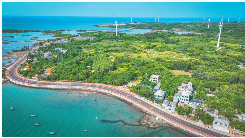
高空俯瞰海南环岛旅游公路儋州火山海岸段。 海南日报全媒体记者 张茂 摄
