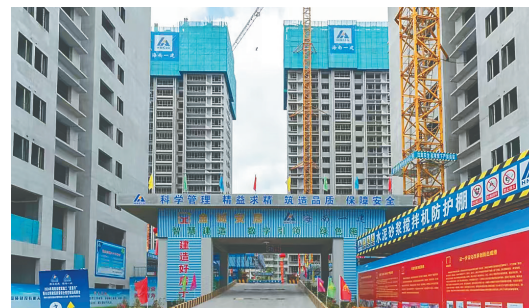
正在建设的金城·金甸水岸项目。
