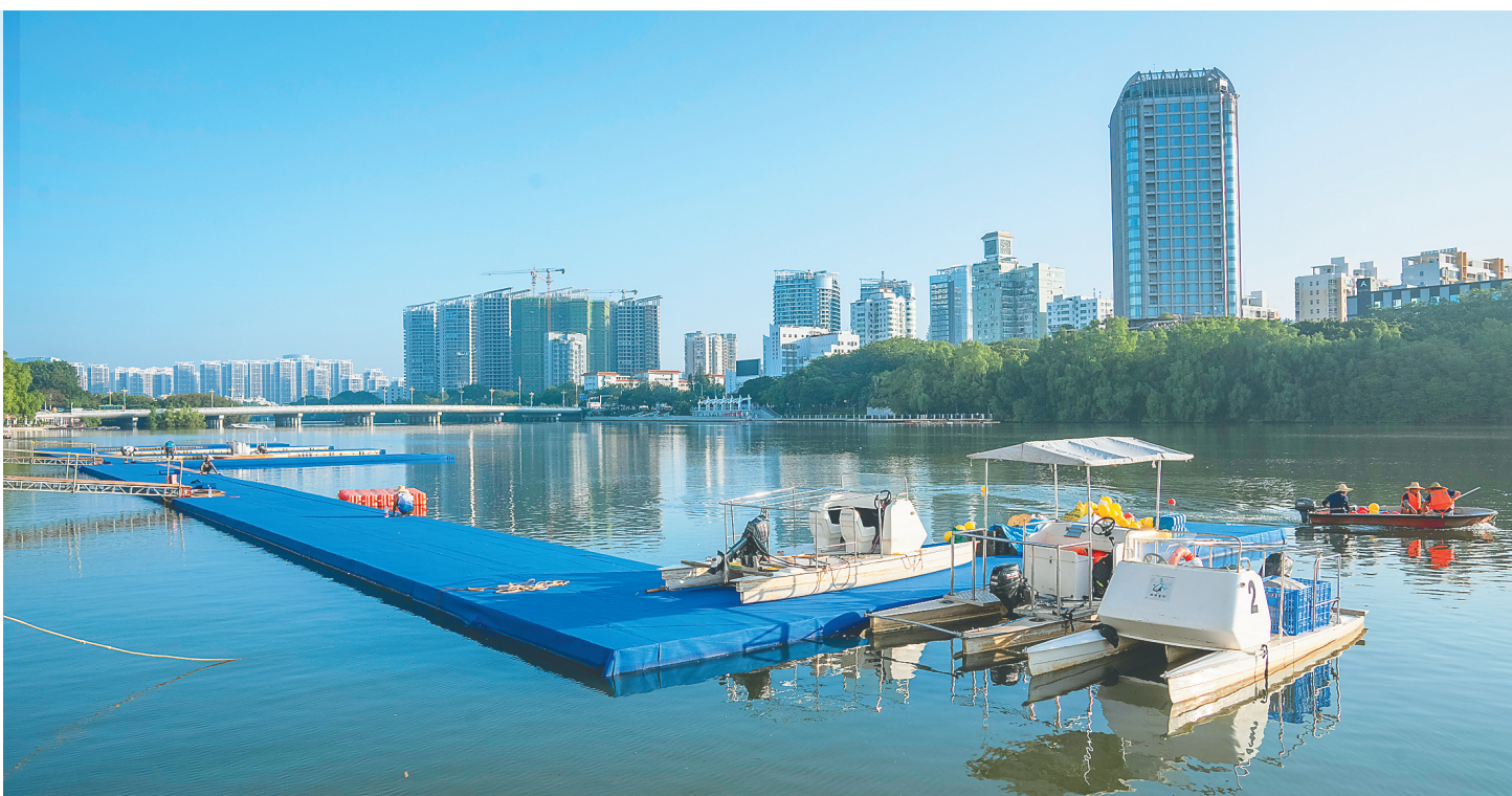
近日，在三亚河上，工作人员正在运动会登岸码头上忙碌。
