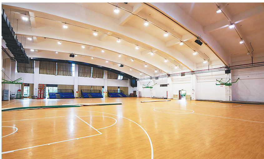
毽球项目场馆、三亚中瑞酒店管理职业学院综合楼位于三亚市海棠区湾坡路108号，地上一层、地下一层结构，其中首层建筑面积4600平方米，座席400座。
