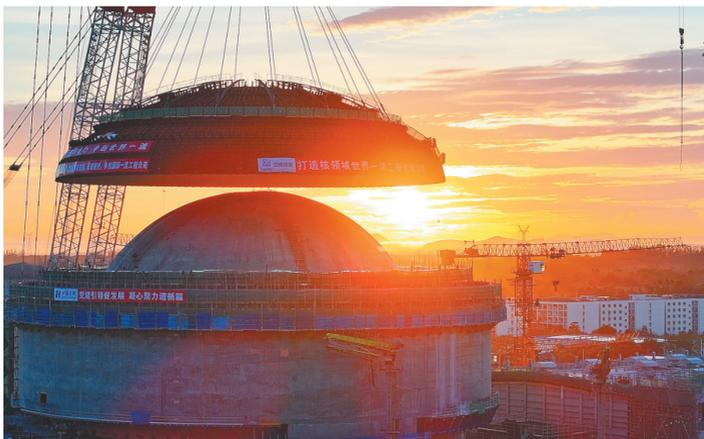
华能海南昌江核电3号机组岛外穹顶模块顺利吊装就位。华能海南昌江核电有限公司供图
