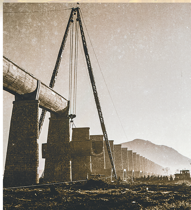
松林岭渡槽建设现场。特约记者 吴文生 供图
