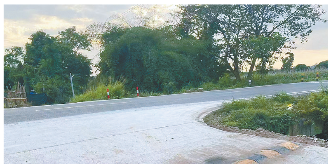
昌江昌化江公路十月田镇姜园村一段公路平交口改造后宽阔平坦。 通讯员 杨萍 摄
