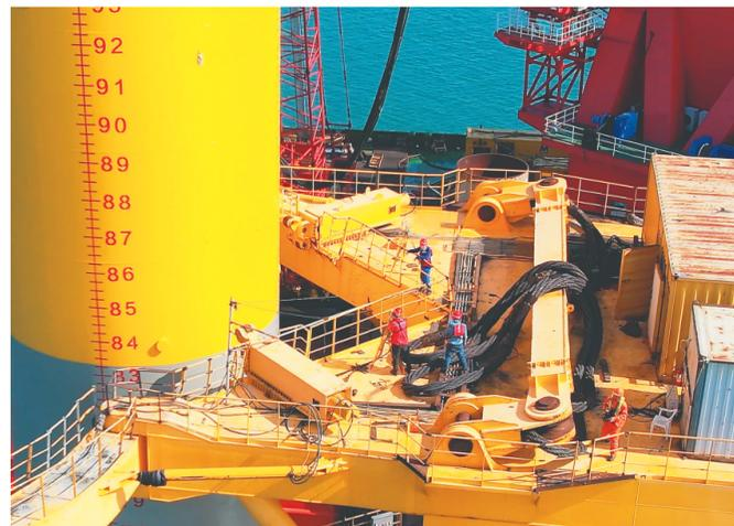
12月11日，大唐海南儋州120万千瓦海上风电项目现场，工作人员正在进行单桩基础沉桩作业。(受访者供图)
