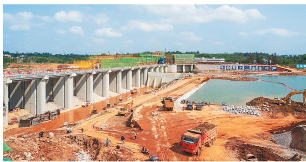
龙塘大坝改造工程预制梁全线上架吊装完成。
