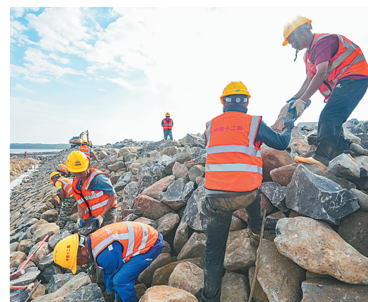
临高金牌港开发区港口及配套工程项目施工现场。海南日报全媒体记者 陈元才 摄
