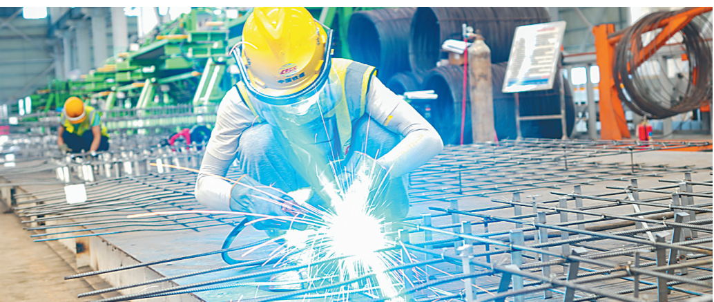
在中铁建设建筑发展(海南)有限公司装配式建筑生产车间，工人加紧生产装配式建筑产品。
