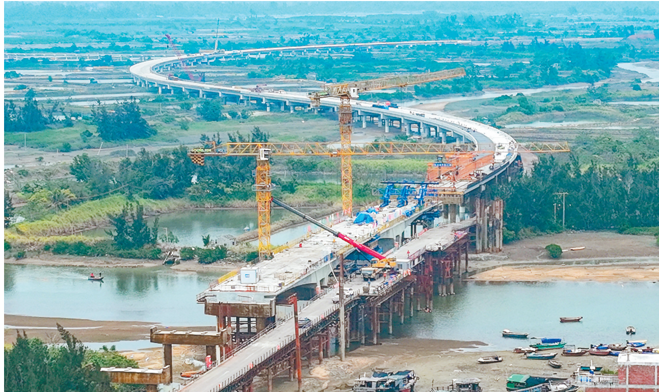
海南环岛旅游公路:环新英湾支线北门江特大桥合龙
