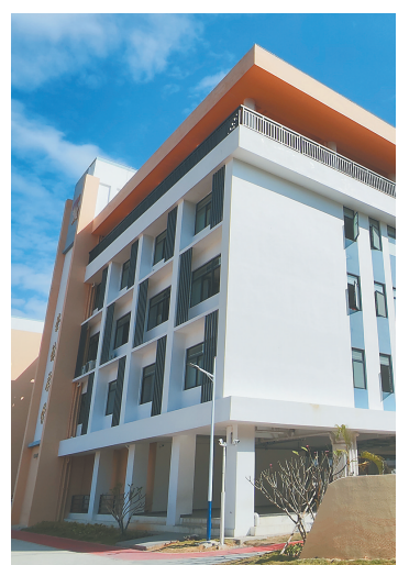
昌江黎族自治县第三小学综合教学楼。海南日报全媒体记者 吴心怡 摄
