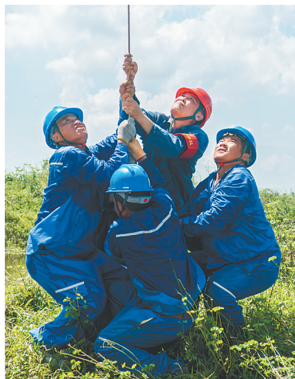
9月13日，超强台风“摩羯”过后，电网工作人员在文昌潭牛镇抢修输电。通讯员 余盛本 摄
