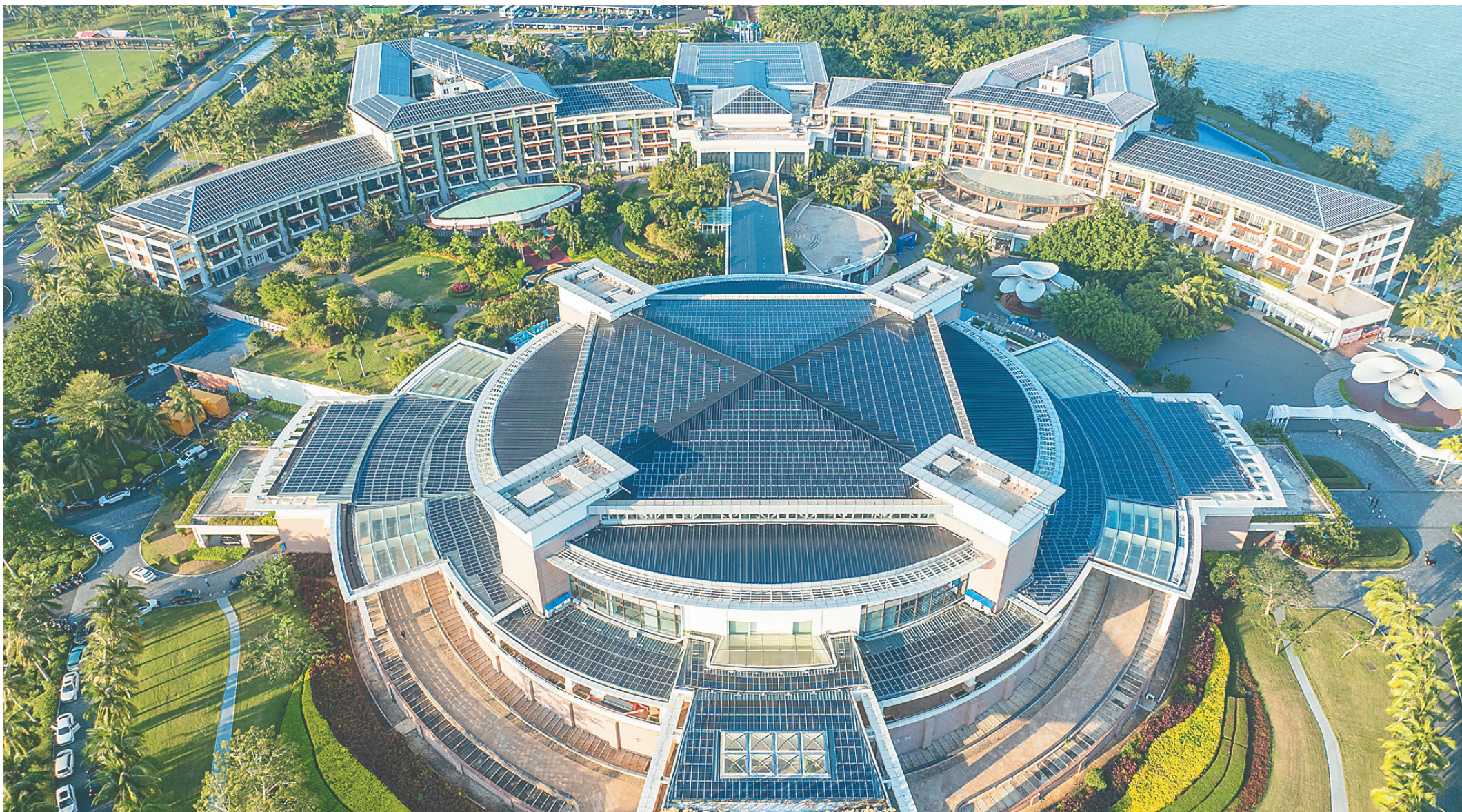
琼海博鳌近零碳示范区屋顶的光伏板。 海南日报全媒体记者 李天平 摄
