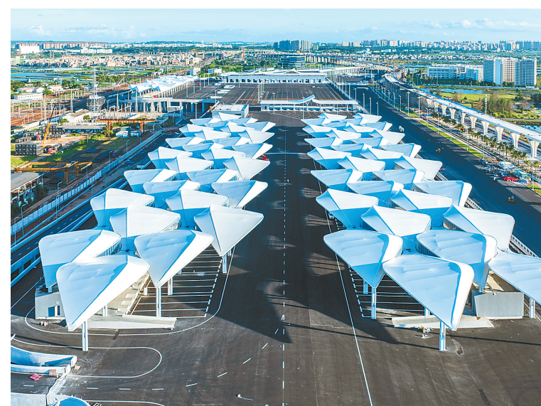
海南省纪委监委持续推进工程招投标等领域“机器管+”智慧监督系统建设，提升监管效率。图为海口新海港和南港“二线口岸”(货运)集中查验场所项目施工现场。 通讯员 杨鹤 摄
