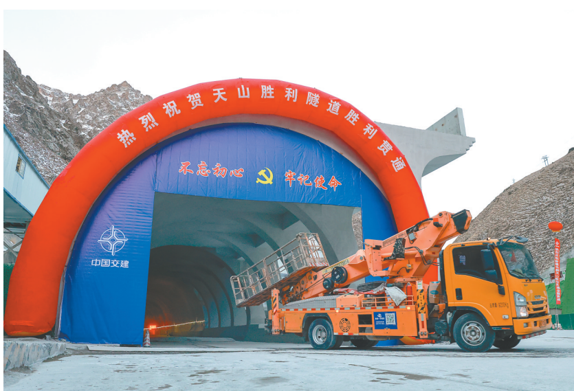
12月30日,工人驾驶工程车驶出天山胜利隧道。 新华社发
