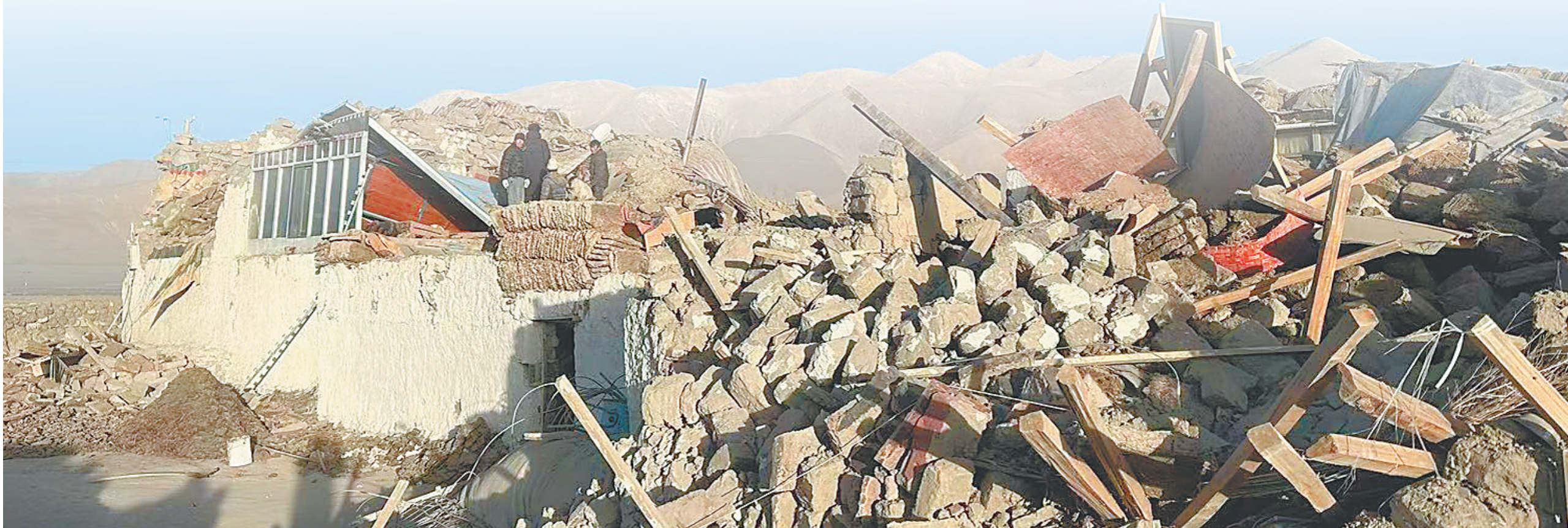
1月7日在日喀则市定日县长所乡通来村拍摄的房屋倒塌情况。 新华社发
