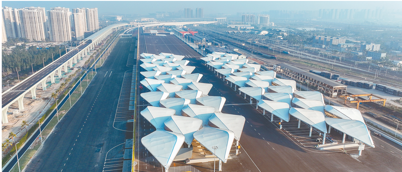
近日，航拍已经竣工的海口新海港和南港“二线口岸”（货运）集中查验场所建设项目。海南日报全媒体记者 张茂 摄
