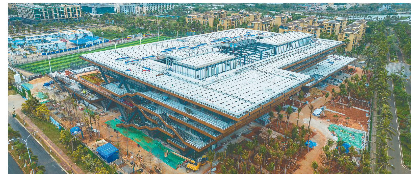
海口市职工活动中心项目: 近日,航拍位于海口江东新区的海口市职工活动中心项目。该项目整体形象进度已超九成,正在进行精装修和机电安装等施工,预计3月底完成全部施工内容。据了解,该项目包括演艺厅、电影院、羽毛球(乒乓球)馆、篮球(排球)馆、游泳馆等设施,投用后将为江东新区新增一座城市文化综合体,满足海口市职工生活休闲的多样化需求。海南日报全媒体记者 张茂 摄
