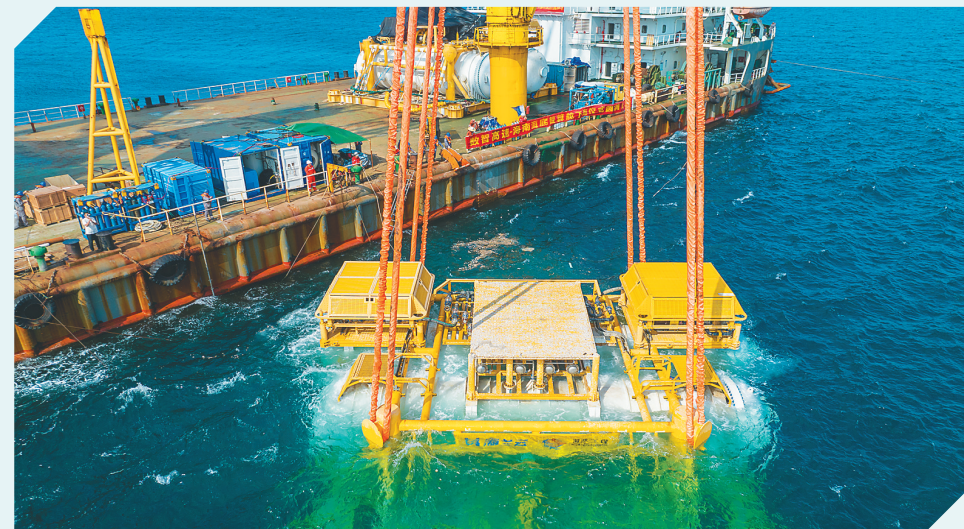
海南海底智算舱在陵水黎族自治县清水湾海域完成下水。(受访者供图)
