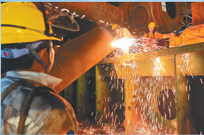
工人在导管架上进行切割施工。
