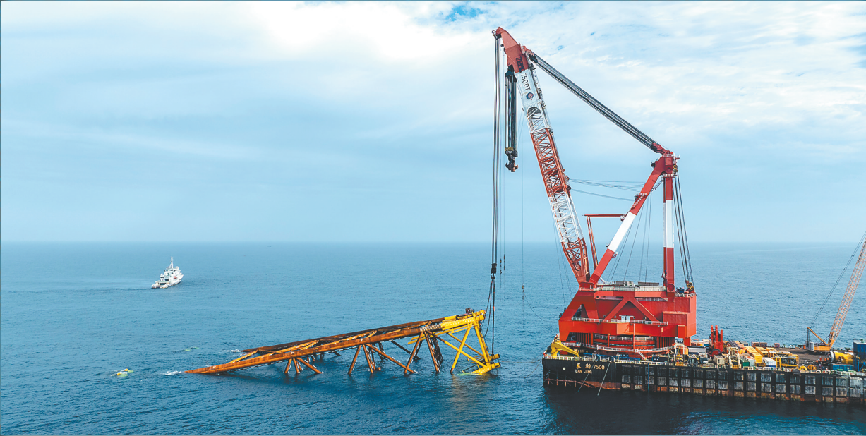
负责此次吊装施工的“蓝鲸7500”船，是我国起重能力最强的海洋油气工程起重船，可同时容纳300余人食宿作业。图为“蓝鲸7500”船对导管架进行起吊扶正。
