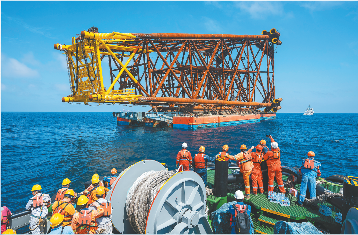
重量逾1万吨的导管架被运输到指定海域，施工人员乘船前往导管架开展切割工作。
