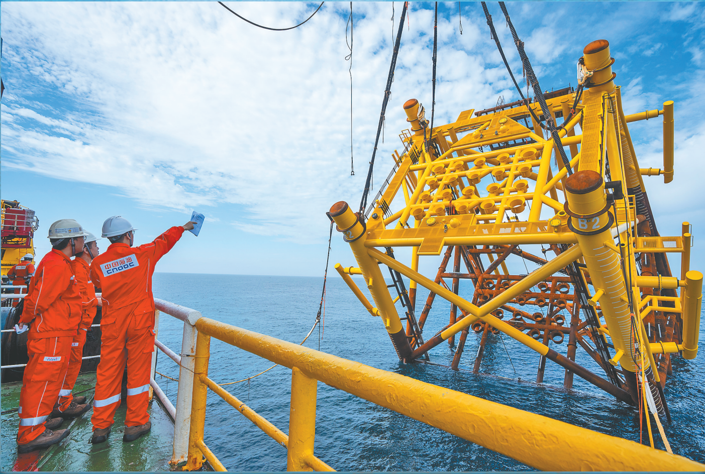
作业人员对施工环节科学研判，确保导管架扶正万无一失。
