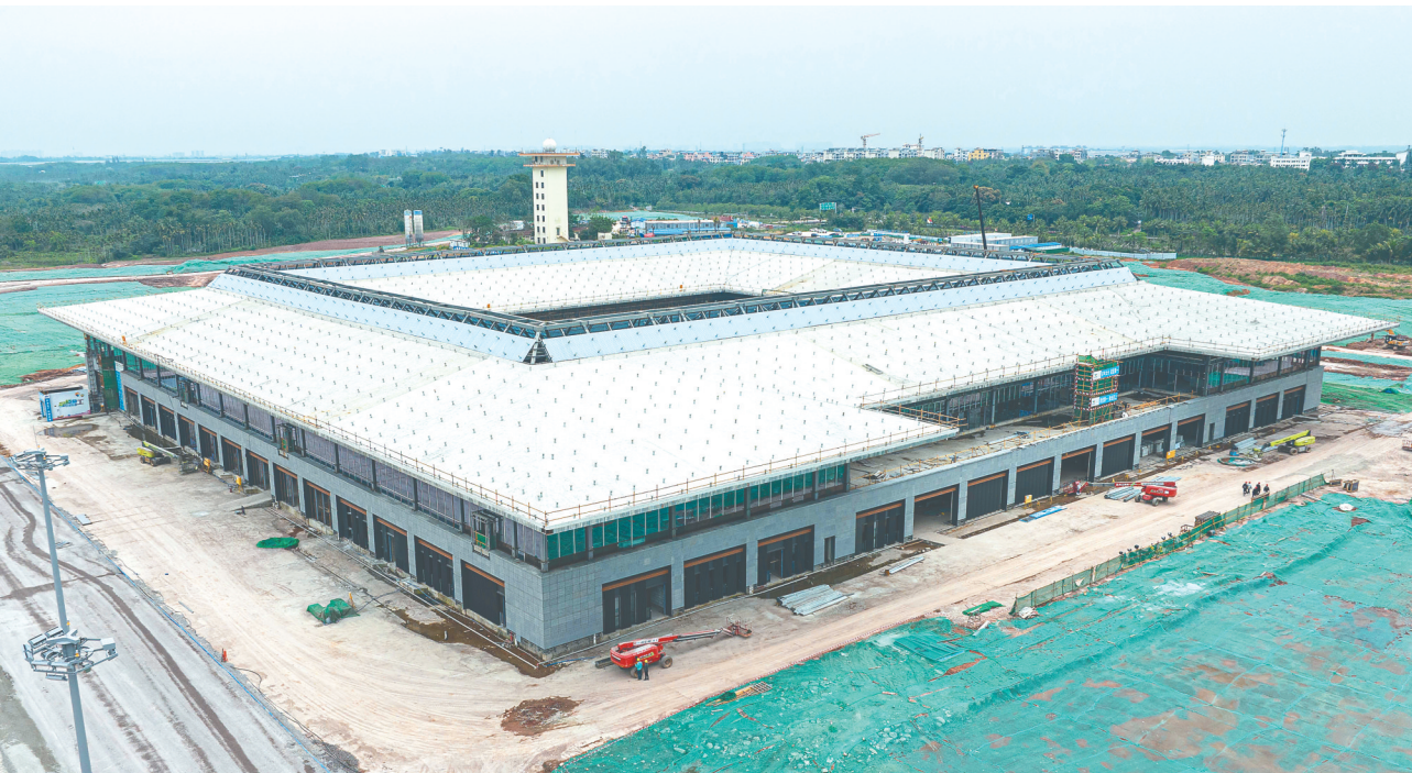
3月19日拍摄的建设中的博鳌机场三期项目T2航站楼(无人机照片)。 新华社记者 蒲晓旭 摄
