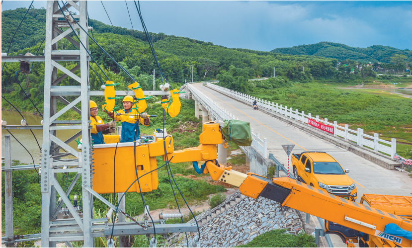
海南电网白沙供电局配电管理中心带电作业班开展不停电作业。 吴清炳 摄
