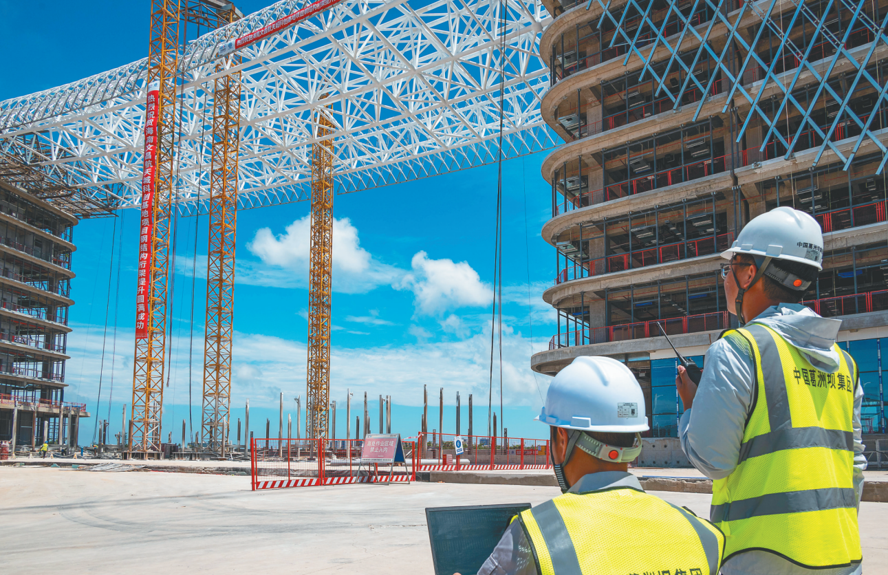
5月17日，文昌国际航天城航天科创基地项目完成钢结构桁架提升安装。 海南日报全媒体记者 袁琛 通讯员 胡骏一 摄
