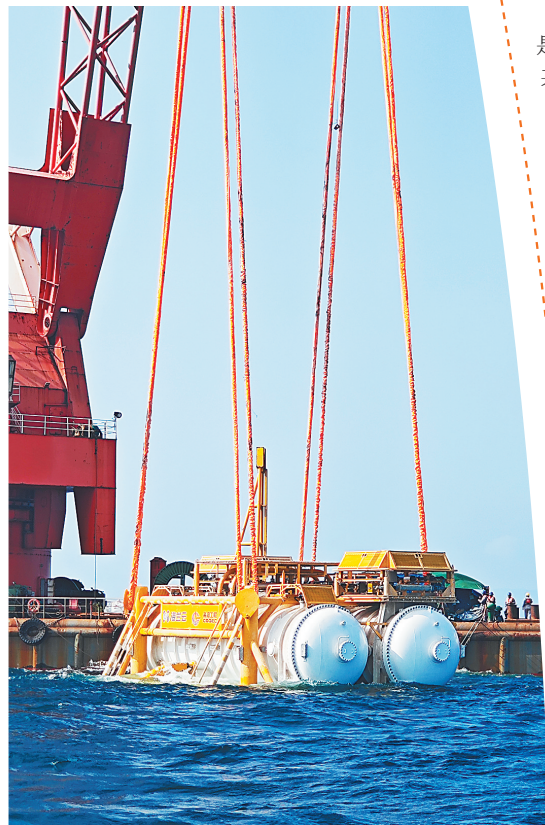
今年2月18日,海南海底智算舱在陵水黎族自治县下水,与正在运营的海底数据中心相链接,标志着海底智算中心正式启用。(资料图)
