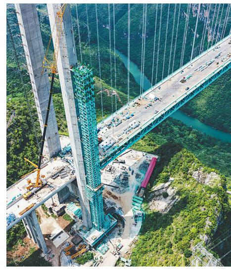
晨曦中，在桥塔顶距离江面800多米的塔吊上，工人们正拆卸施工龙门架、给大桥安装电梯。这里是在建世界第一高桥——花江峡谷大桥建设现场。
