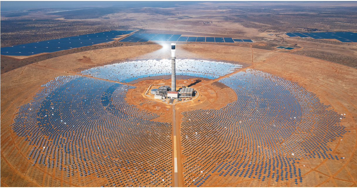
图为2024年8月20日在南非北开普省拍摄的南非红石100兆瓦塔式熔盐光热电站项目。
