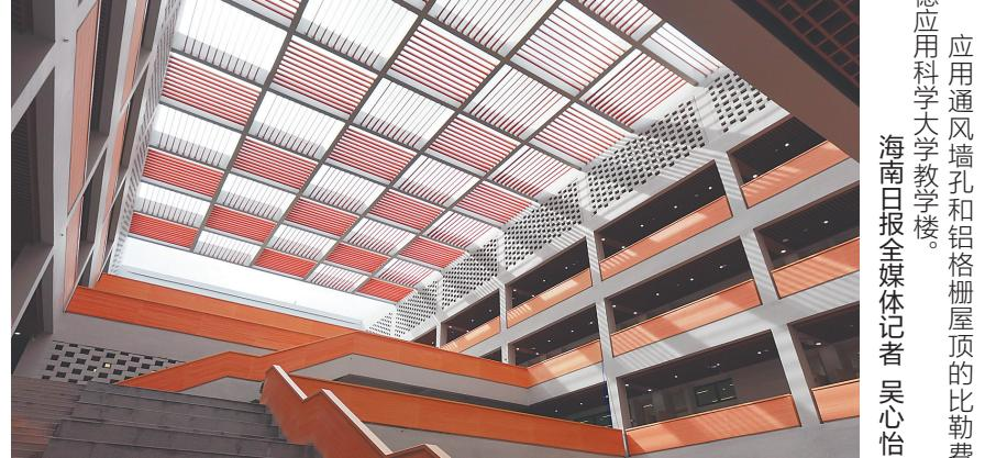
风”的建筑。看四面墙,砖块以镂空形式摆放,整面墙的孔洞为“穿堂风”留下宽阔的通道。抬头往上看,屋顶是横竖交错的铝格栅设计,形似拉开的百叶窗。“教学楼利用底层架空和内部开放中庭,形成‘烟囱效应’,增强自然通风,改善微气候,提升建筑的整体舒适度。”项目施工方、中铁四局比科大项目经理王伟介绍。
