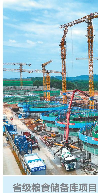
近日,位于琼中湾岭镇的省级粮食储备库项目成功冲出“正负零”,全面转入地上主体结构施工阶段。该项目规划建设28座浅圆仓和2栋楼房,总仓容达30万吨,是我省投资规模最大、现代化程度最高的省级粮食仓储项目。
