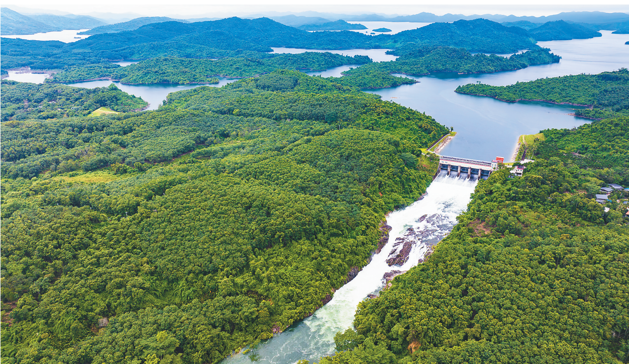
松涛水库开闸泄洪 7月20日，航拍松涛水库。为做好今年第6号台风“韦帕”防御工作，19日晚，松涛水库启动泄洪，水库溢洪道五孔闸门缓缓开启，水流以200立方米/秒流量，向南渡江下游奔腾而去。 海南日报特约记者 吴文生 摄
