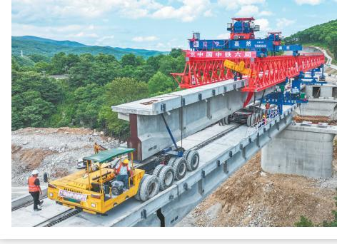
7月20日，滨绥铁路绥芬河至国境线提质改造工程绥芬河特大桥完成全部T梁架设，为后续线路铺设奠定了坚实基础。
