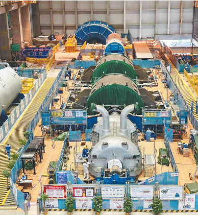
华能海南昌江核电二期工程项目3号机组汽轮机扣盖完成。 本栏图片均由黄钰坤摄
