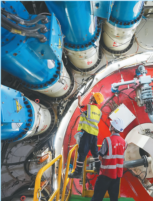
技术人员在甬甬铁路金塘海底隧道“定海号”盾构机内关注设备运行情况。
