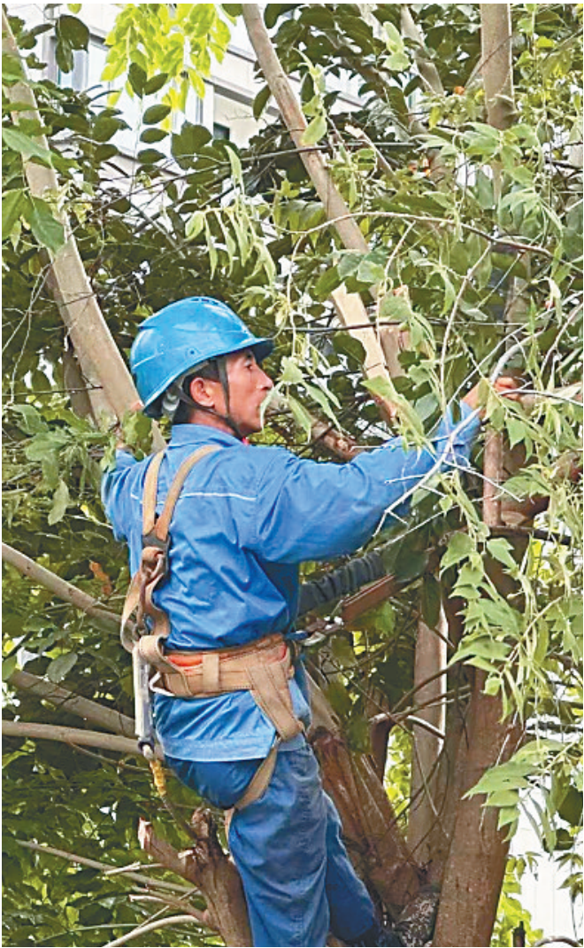
台风来临前，海南电网陵水供电局工作人员在清理线路周边树障。
