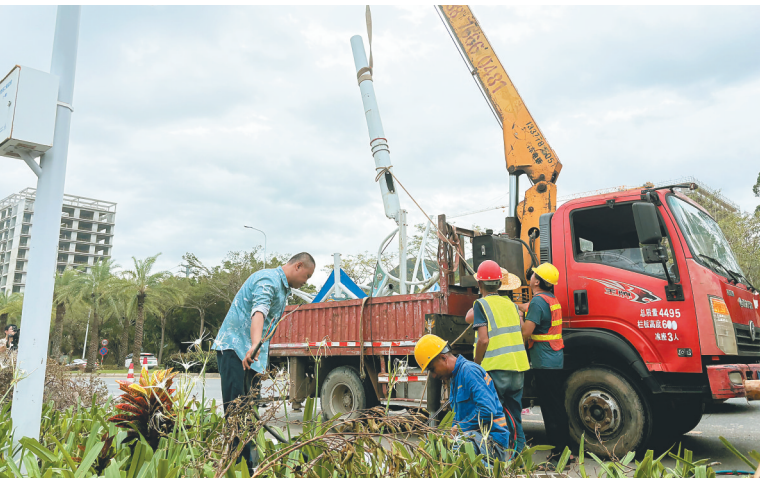
维修工人在移除损坏的灯杆。目前,三亚吉阳大道等多条主干道路灯已抢修完工。
