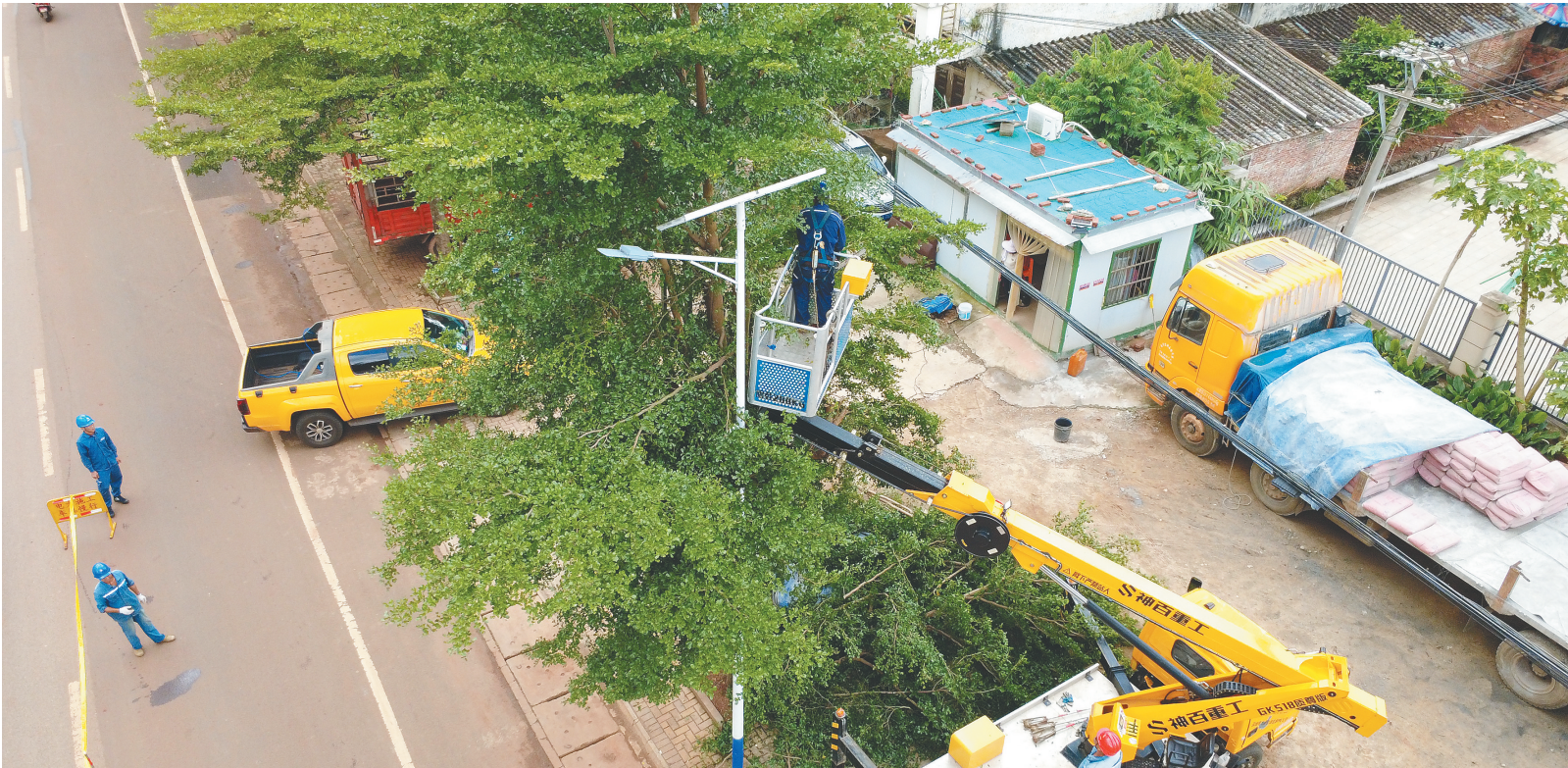
9月22日，海南电网澄迈供电局工作人员对10千伏关键线路开展树障清理工作。通讯员 许家俊 摄
