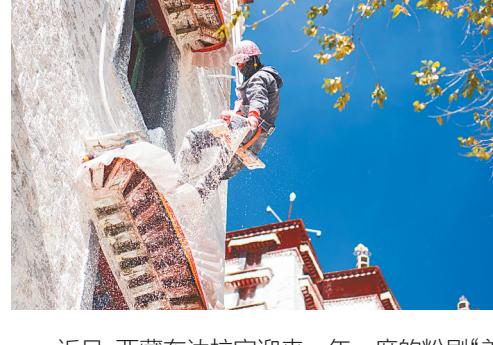
近日，西藏布达拉宫迎来一年一度的粉刷“美容”。工作人员和志愿者将粉刷材料按比例混合，经过滤后对布达拉宫墙体进行喷涂，让建筑更加美观。
