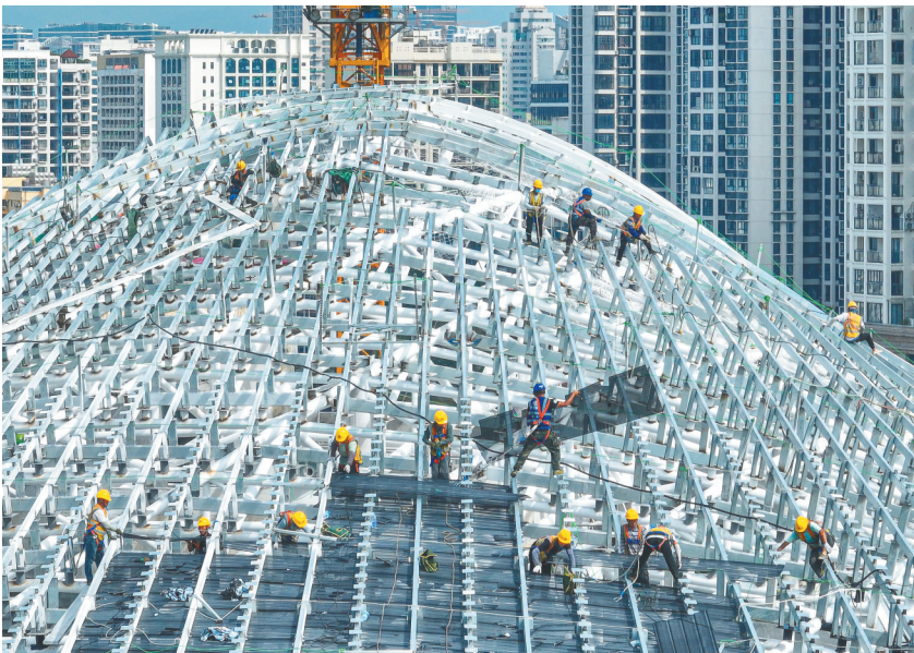
11月12日，位于三亚中央商务区的中国海南国际文物艺术品交易中心，工人们在屋面组装钢结构。海南日报全媒体记者 王程龙 摄
