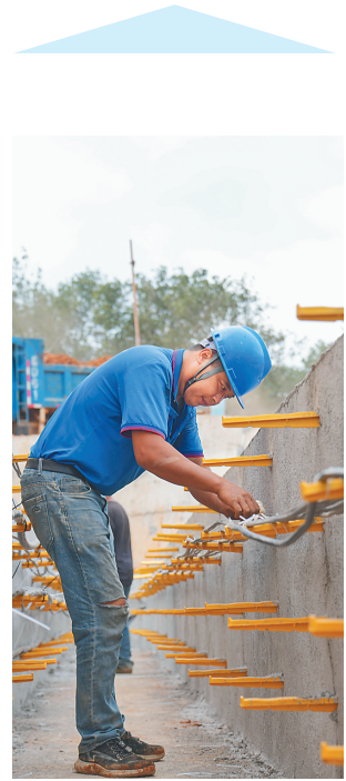
乐东万冲镇自来水厂及配套管网工程项目施工现场，工人正在进行电缆安装等收尾作业。
