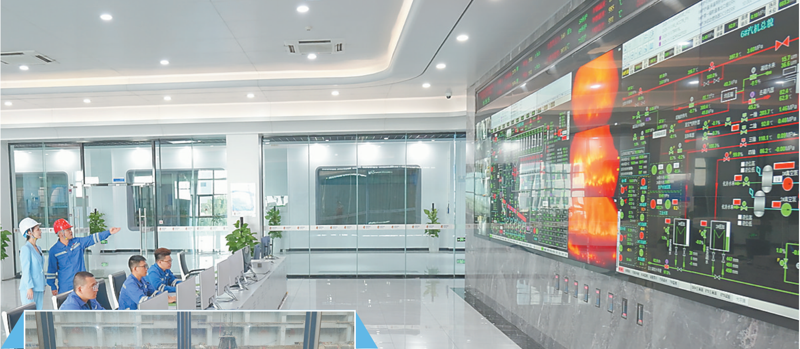
在中电绿能海南公司海口环保发电项目三期中央控制室，技术人员依托大屏与终端的实时数据，监控各环节的运行状态。
