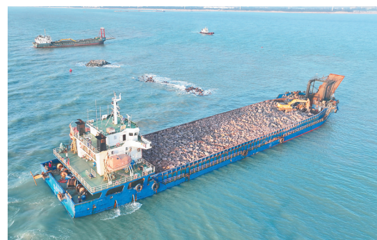
图为八所港高排港区防波堤抛石作业中。 中交广航局八所港防波堤项目部提供
