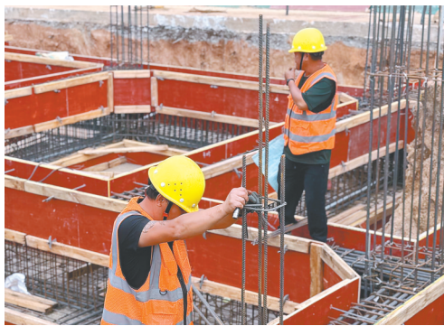
昌江思源实验学校综合教学楼建设现场,工人在绑扎钢筋。
