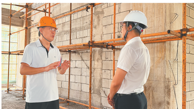
4月10日，鲁科检测科技(海南)有限公司人工智能无损检测仪器智造项目现场，企业负责人(左)向政府工作人员介绍项目进展。
