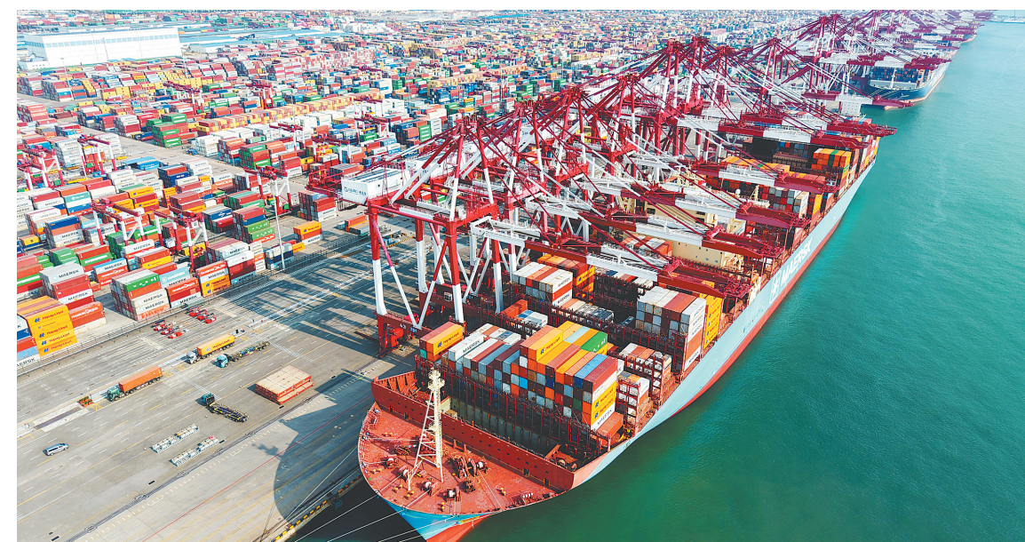
三月十日,在山东港口青岛港外贸集装箱码头作业一派繁忙。新华社发
